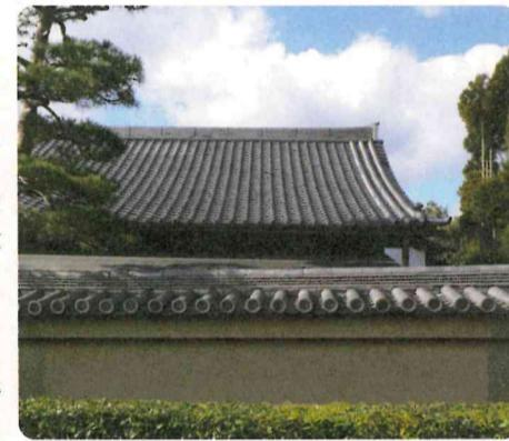
を使った瓦の載せ方をしていました。屋根の野地板の上に厚く土を載せて、その上に瓦を並べてゆくのです。そのため瓦屋根の仕事は、左官が手がける仕事でもあったのです。
