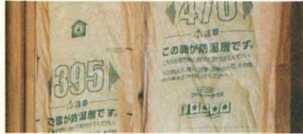
綿状の断熱材よりも板状の断熱材の方が、吸水性などを考えると多少是有利と考えられますが、しっかり防水層をシールすることは欠かせません。防水層の外側に断熱材を配置するのは、すべての家の鉄則です。
