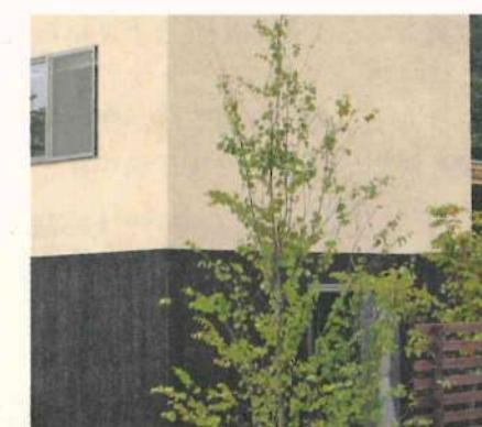
最後にALCはコンクリート系のサイディングです。蒸気養生した軽量気泡コンクリート(ALC)板を外壁として張ります。木造の家でも外壁はコンクリートの家のようになります。ALCには表面に気泡があるので吸湿性があるので、表面はしっかりと防水塗装をしなければなりません。もちろんコンクリートと名がついているので火や劣化に強い材料です。
