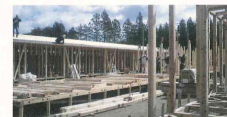
その量とスピードは、まさに工業化が進んでいることの象徴でもあります。製材された木材から、これまで大工さんが行なっていた現場での木材の加工は、すでに全国で800を越える工場で加工されて現場で組み立てるだけで建てられます。じつは在来木造のプレハブ化が浸透しているのです。
