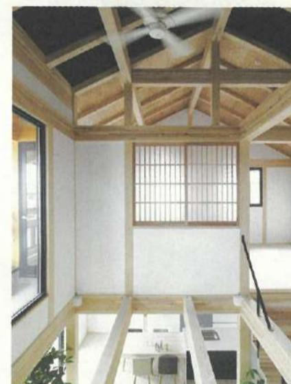
また、柱材よりも梁材の方が大きな断面を必要とするので、乾燥はより難しくなります。
