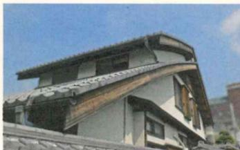
影響を及ぼす可能性が高まります。逆に考えれば、鼻隠しや破風の劣化がメンテナンスの合図となり、適切な時期に修繕や交換を行うことを知らせてくれているのです。腐らせる部材があるからこそ、腐ることを防げるのです。
